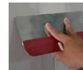
Figura 49 - Aplicação final do rejunte sobre a fita
