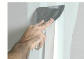
Figura 48 - Aplicação da fita
