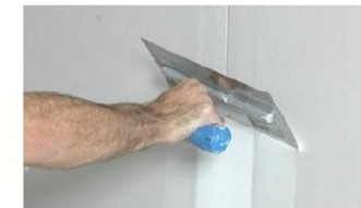
Figura 47 - Aplicação da 1ª camada de rejunte
