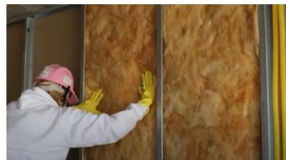
Figura 44 – Colocação da lã entre os montantes
