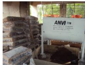
Figura 4 – Central de dosagem de argamassa
