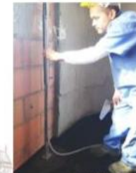
Foto 16: Execução de talisca com nível alemão.
