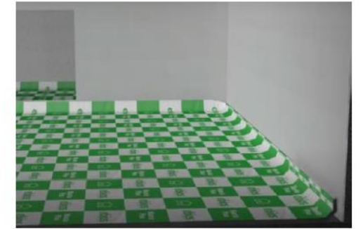
Figura 13: Detalhe da manta do rodapé e piso.
