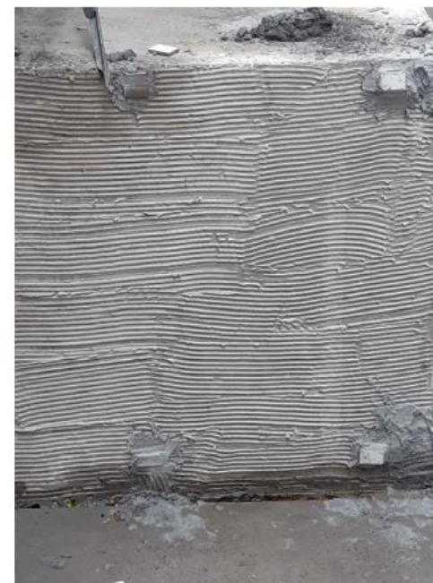
FOTO 1: CHAPISCO EXECUTADO COM DESEMPENADEIRA E TALISCAS
