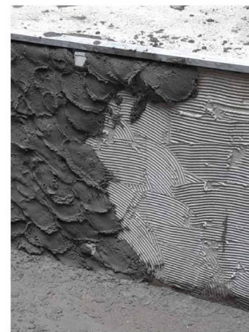
FOTO 2: EXECUÇÃO DA CAMADA DE REGULARIZAÇÃO DE ARGAMASSA
