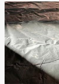
Figura 3: Distribuição da lona sobre a camada de brita
