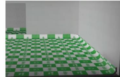
Detalhe da manta do rodapé e piso.
