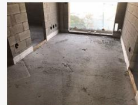
Figura 3 – Fôrmas de madeira para parada do contrapiso autoadensável
