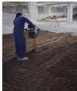
Figura 1: Compactação mecânica do subleito
